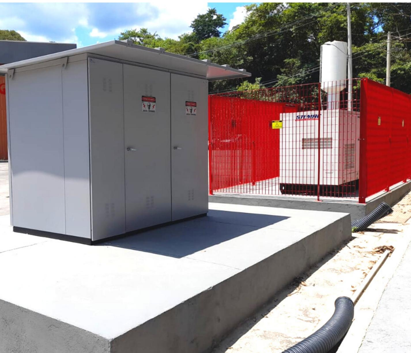
Obra de instalação de Cabine Primária, Subestação com transformador, cabeamento de potência e comando.
