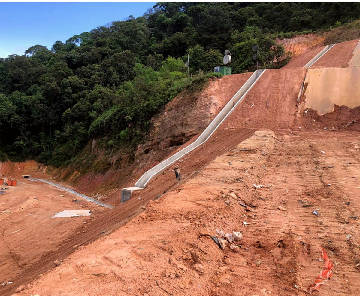
Elaboração de projeto e execução de todas as etapas da obra que teve como objetivo o escoamento da água pluvial do Aterro, prevenindo o acúmulo de água entre os taludes e evitando a instabilidade no solo.
